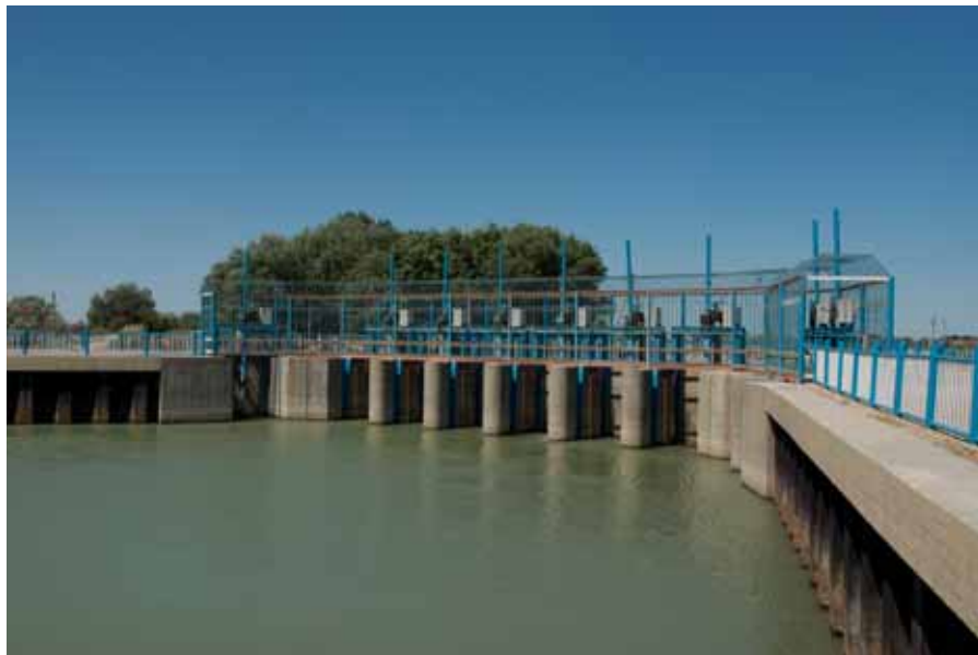
Spuisluizen in de Syr Darya op 500 kilometer van het Aralmeer reguleren de waterdoorvoer.
