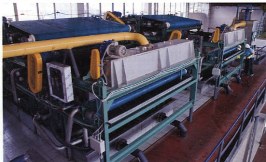
De twee bandzeefindikers zorgen voor vermindering van stankoverlast.
